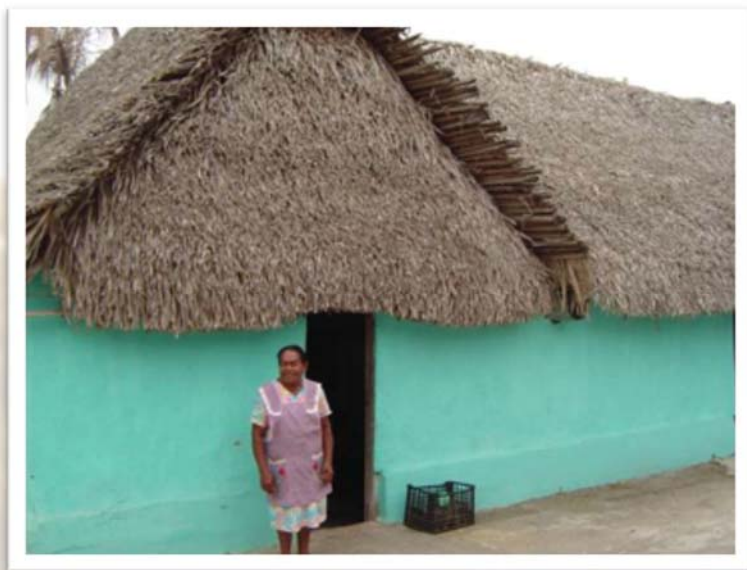
Figura 5. Señora en su casita de la costa veracruzana, elaborada con diferentes materiales naturales. El techo está construido con hojas de la palma de coyol real y las paredes con el tallo de la palma real, cubierto con adobe y pintura verde. Fotografía R.M. González Marín.
